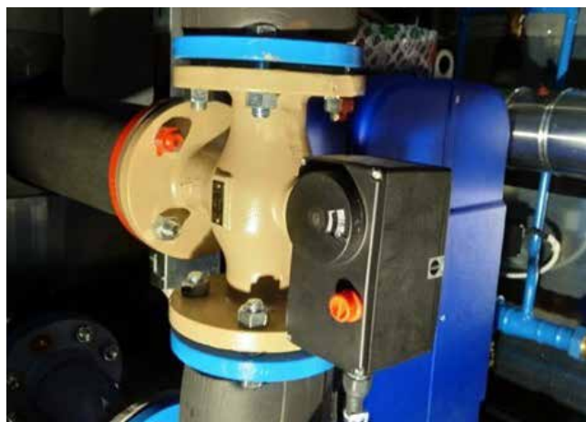
Slika 3 : Regulacijski ventil Samson tip 3260
