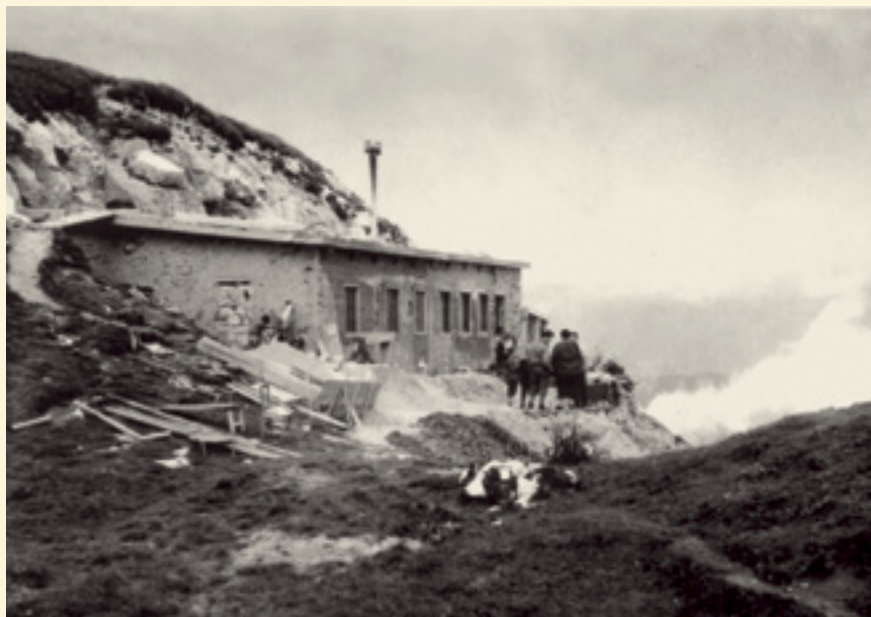
Priprave za obnovo koče
