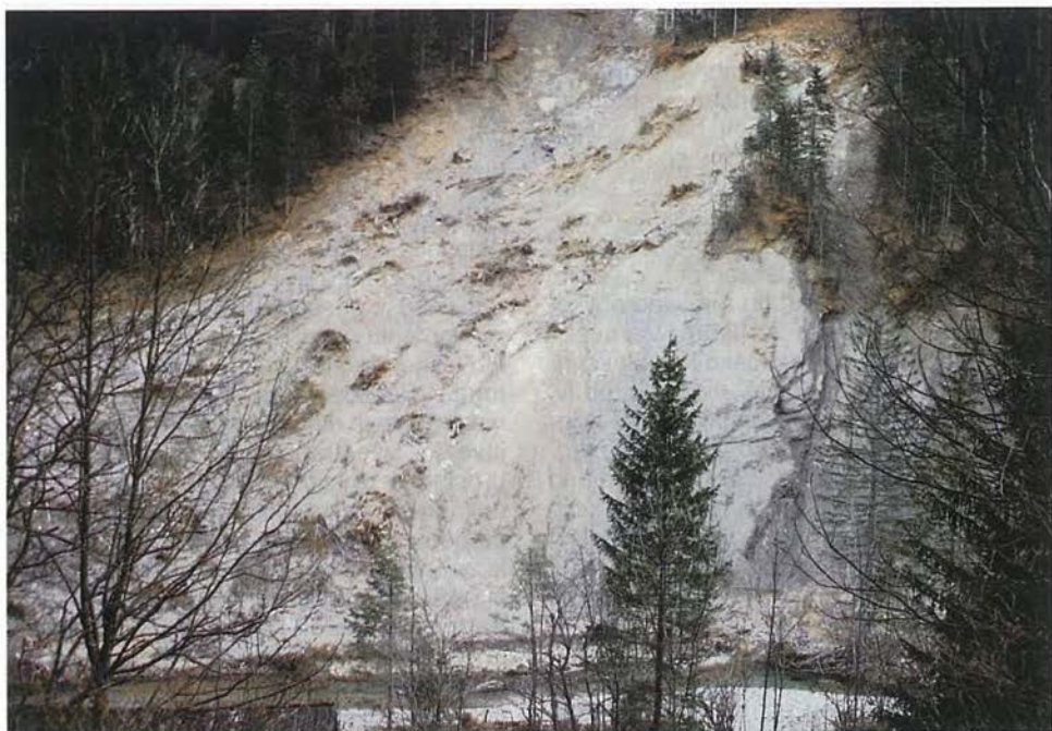
Vzrok zemeljskemu plazu pod Grobelskim vrhom je bilo spodjedanje brežine, ki ga je povzročila Lučnica (foto: Rok Ferme)
