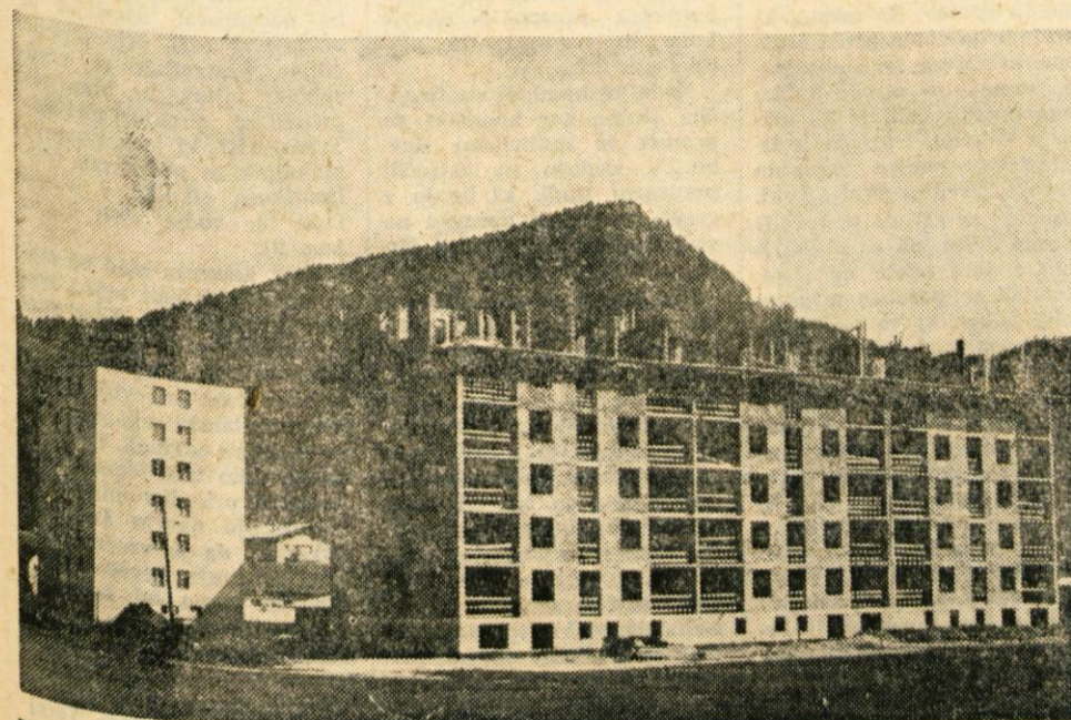
V Perovem pri Kamniku gradi Splošno gradbeno podjetje Projekt Kranj 48 stanovanj za trg. Med dvosobnimi, trosobnimi stanovanji in garsonjerami jih bo ena tretjina vseljivih že letos, druga pa prihodnje leto — Foto F. Perdan
