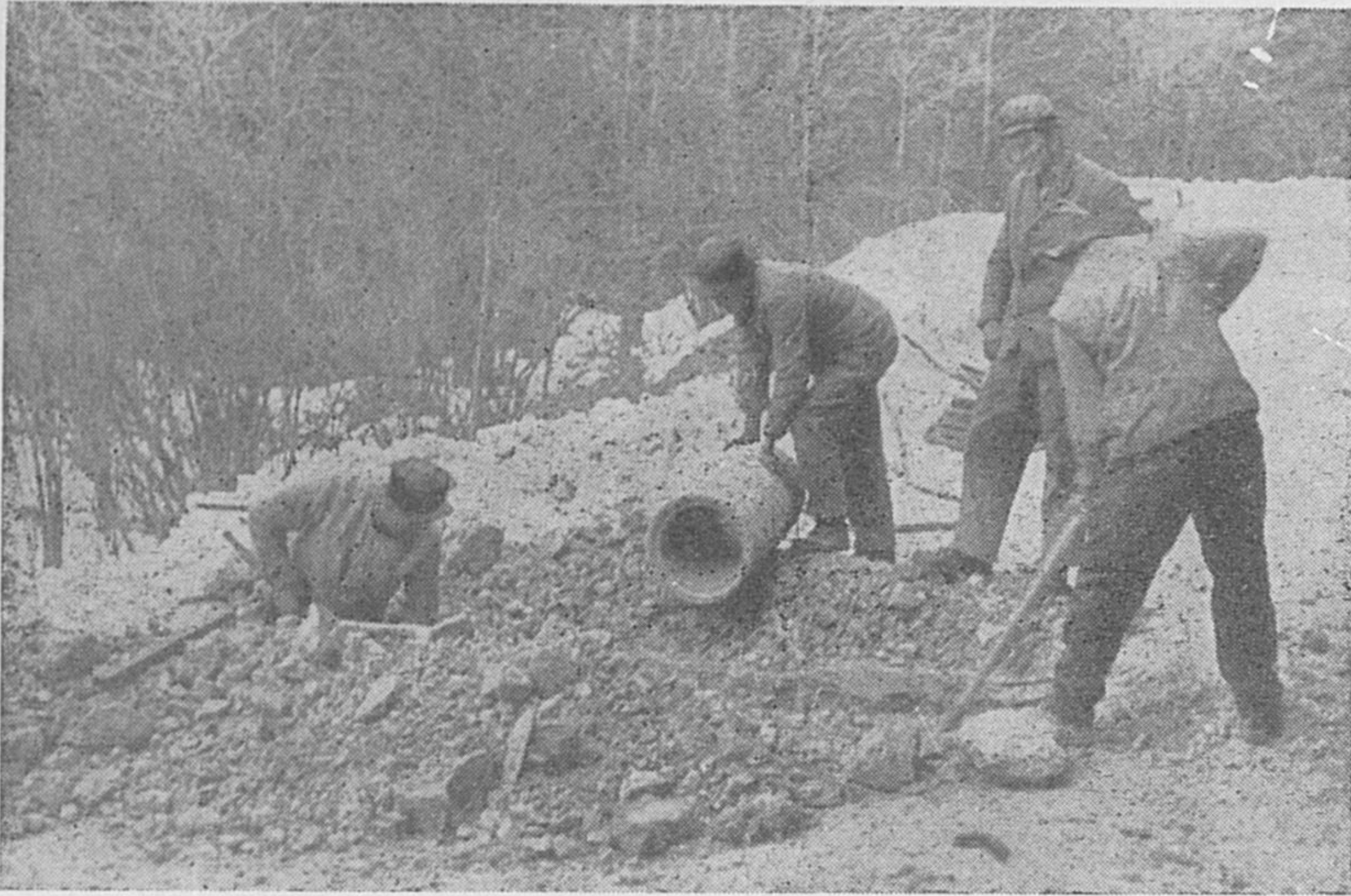
Skupino delavcev Cestnega podjetja Ljubljana smo zmotili pri njihovem delu, ko so na Jermendolu postavljali odtočne cevi v globoko zmrznjeno in stlačeno cestišče republiške ceste, ki po tej strani našo republiko povezuje s sosednjo Hrvaško. Povedali so, da bo njihovih skrbi konec takrat, ko bo cesta asfaltirana. O tem, kdaj naj bi to bilo, pa smo lahko ugibali. Seveda tudi mi želimo, da bi bilo čimprej.
