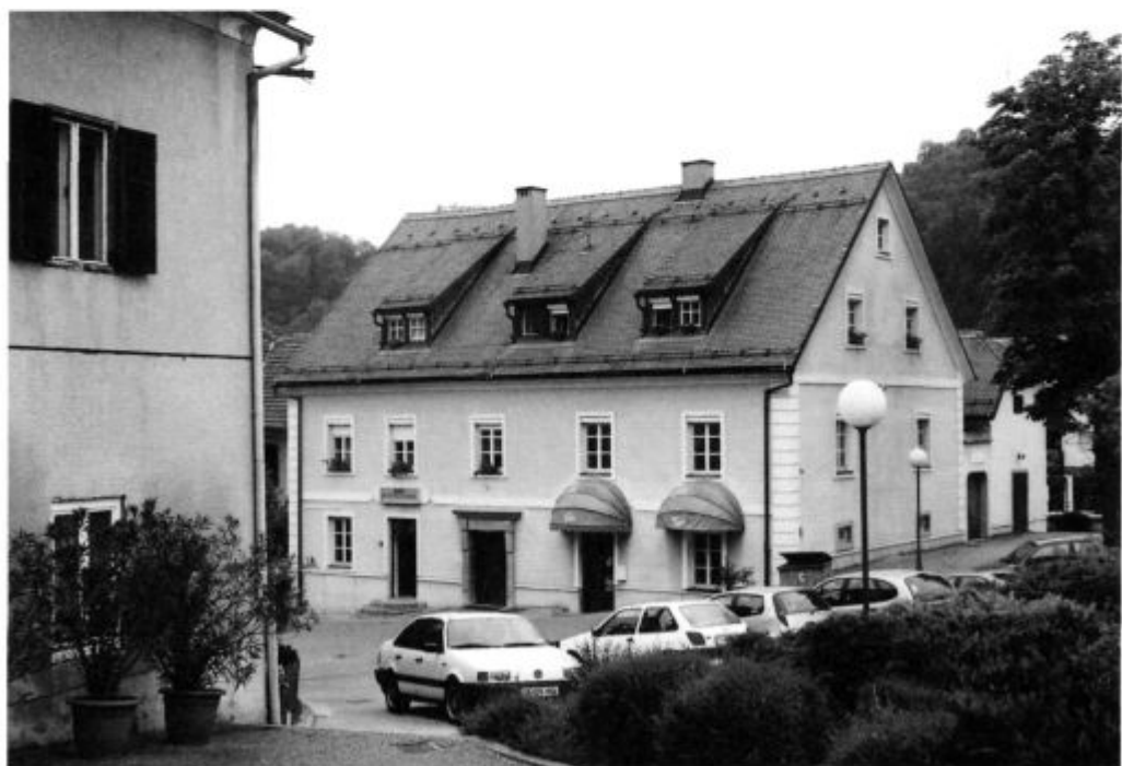
Hiša na Aškerčevem trgu 1 pred obnovo in po njej
