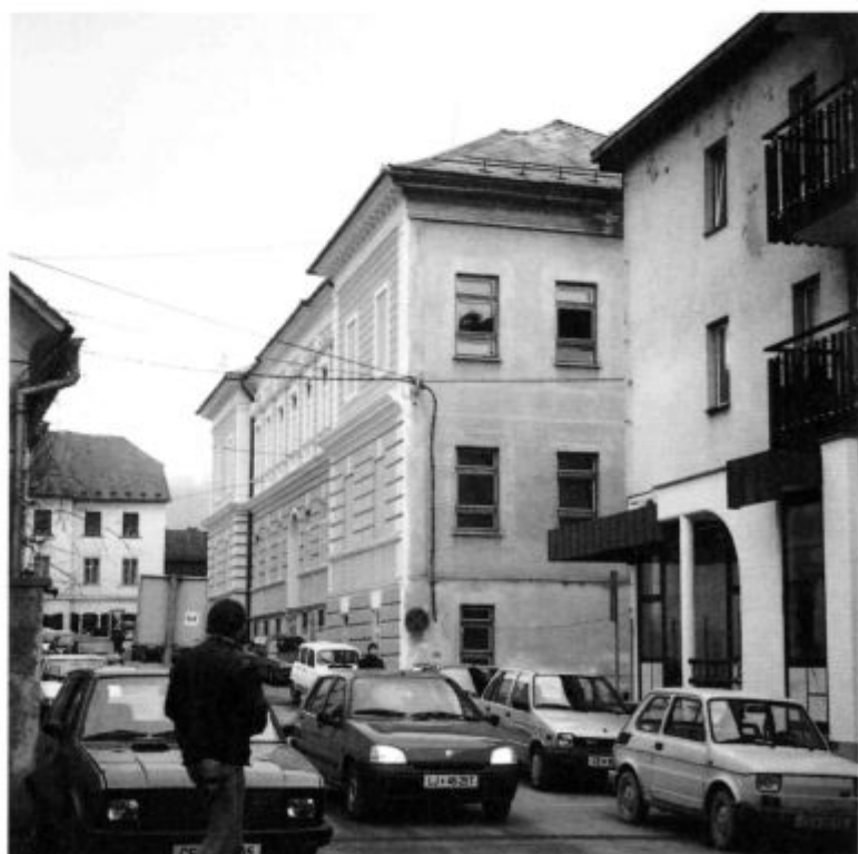
Hotel Savinja in Šola s prilagojenim programom po obnovi
