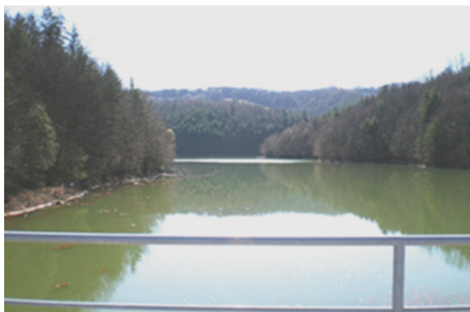
Slika 9 • Izpust in preliv akumulacije Mola.
