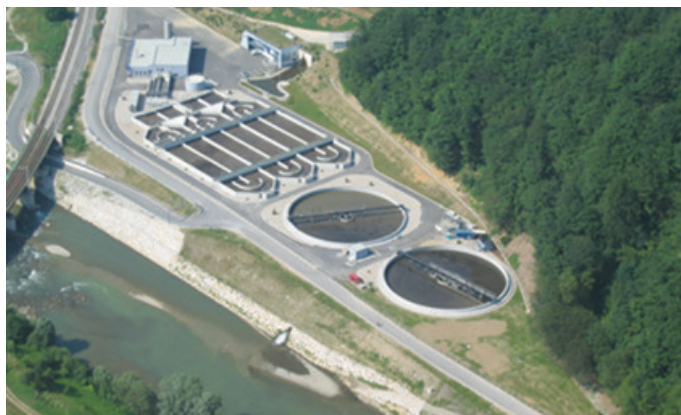
Slika 26 • Tehnološko-ekonomsko utemeljena čistilna naprava za Celje 80.000 PE z denitrifikacijo in defosfatizacijo je podobna tisti, ki je bila zgrajena 1980. na Ptuj.
