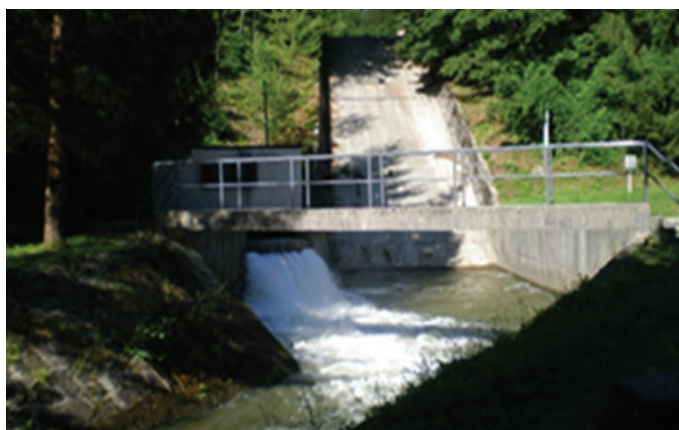
Slika 8 • Izpust in preliv akumulacije Mola.
