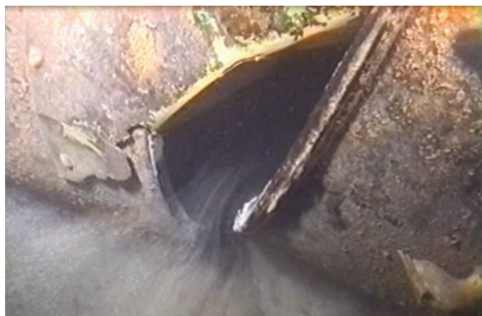
Slika 5 • Namerno nasilno narejena odprtina na zahodnem kraku natege (poleg drugih na vzhodnem kraku), s katero so nategi preprečili odzemanje onesnažene vode z dna jezera ((Rismal, 1999), (Rismal, 2004), (Rismal, 2011))
