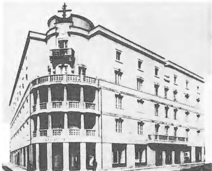
Pročelje Ljudske posojilnice v Celju. Stavbo je načrtoval Jože Plečnik, gradil pa Konrad Gologranc
