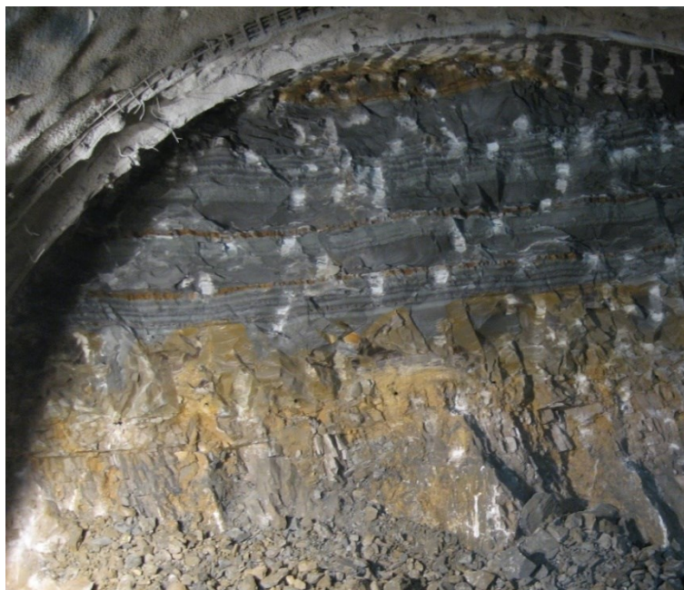
Slika 2.2: Pogled na izkopno čelo leve cevi predora Markovec v flišu, z menjavanjem laporovca in peščenjaka v zgornjem delu ter megaplastjo kalkarenita v spodnjem delu (stacionaža km 0+109,70).
