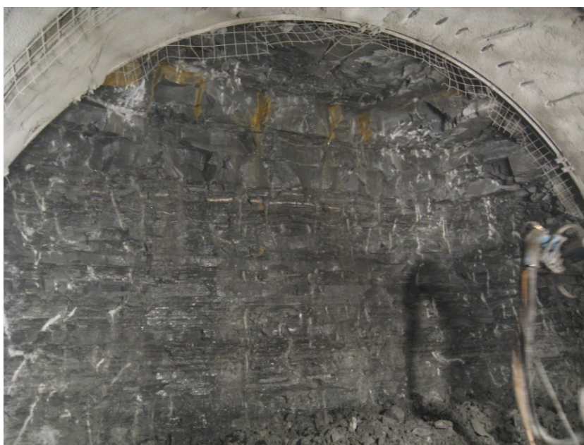
Slika 3.6: Izkopno čelo v flišu (predor Markovec, Koper); določena vrednost RMR: 38-44 (slaba do zadovoljiva hribina), GSI: 37-43 (IV).
