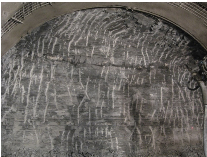
Slika 3.5: Izkopno čelo v flišu (predor Markovec, Koper); določena vrednost RMR: 50 (zadovoljiva hribina), GSI: 43-47 (V).
