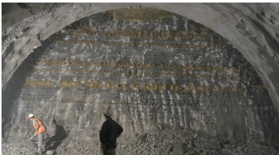
Slika 4.49: Pogled na izkopno čelo v flišu leve predorske cevi predora Markovec na stacionaži km 0+252,4. Na izkopnem čelu so vidne plasti temno sivega laporovca in svetlo sivega peščenjaka. Nekatere debelejšje plasti peščenjaka so zmerno močno preperete in oksidirane.
