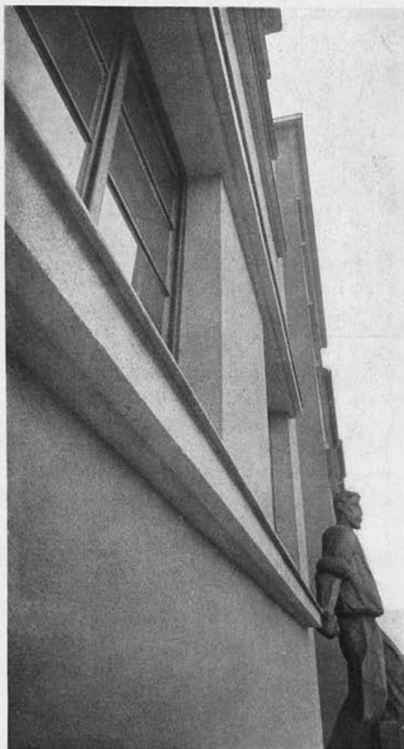
Ing. arch. Fatur, Kos, Platner: „Hranilni in posojilni konzorcij“ Detajl fasade s kipom
