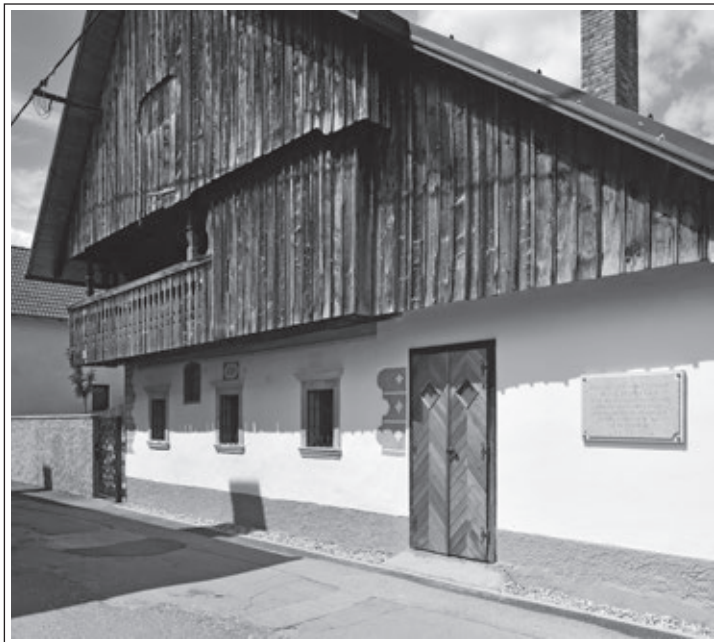
Pogled na obnovljeno Kumerdejevo rojstno hišo na Zagoriški ulici na Bledu (foto: Miran Kambič, 2010).
