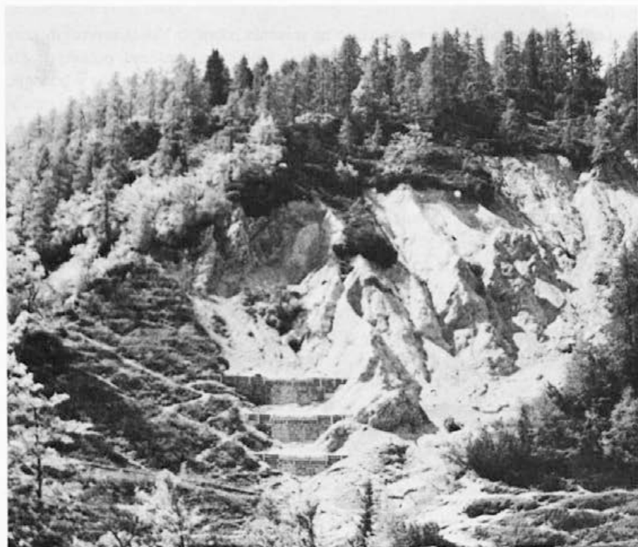
Sl. 5. Erozijsko žarišče v drobljivem anizijskem dolomitu pri Erjavčevi koči, ki ima značaj pravega badlanda, kjer skušajo omejiti denudacijske in erozijske procese s hudourniškimi pregradami in z ozelenjevanjem. Foto J. Kunaver.
