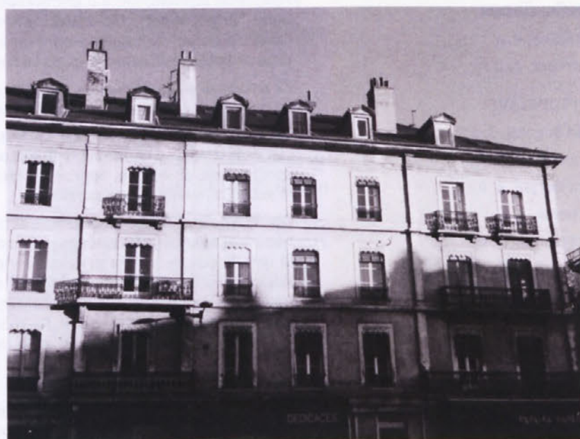
Stavba je postala platno soncu. (Jutranji vzhod v Grenoblu.)
