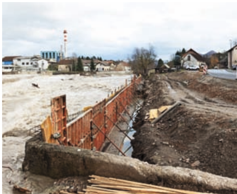
Na območju pri kopališču v Goričanah bodo sanirali tudi brežino.
