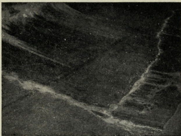
Zasigane razpoke v dnu rova
