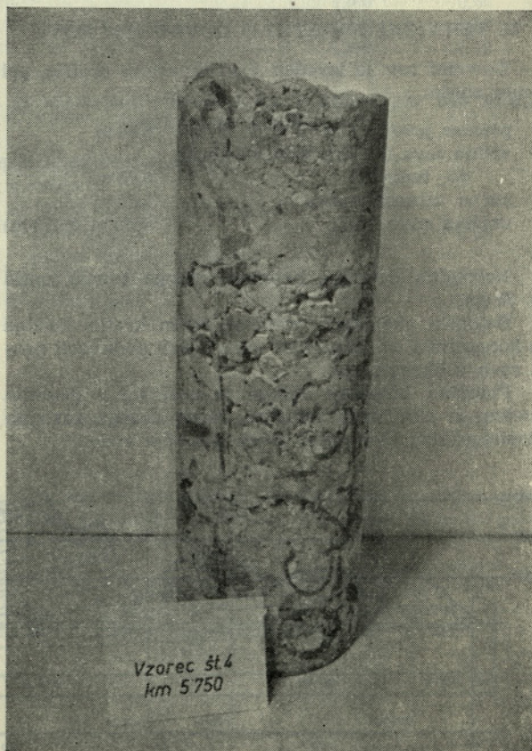
Vzorec betona, izvrtan iz dna rova
