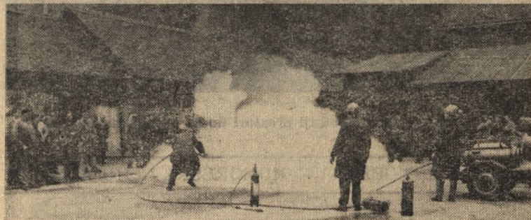
Demonstracija uporabe gasilnih aparatov za delavce mehanične in električne delavnice
