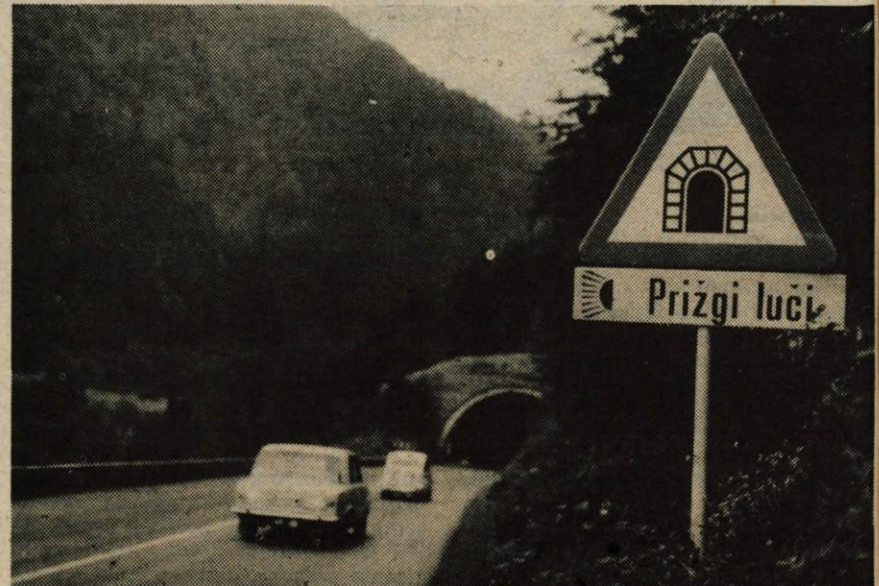
Kljub opozorilnemu znaku, da se bliža nevaren predor in je treba prižgati luči, še vedno najdemo voznike, ki se na opozorilo požvižgajo in v temi zdivjajo skozi nevaren in za zdaj še neosvetljen srednji predor na ljubeljski cesti
