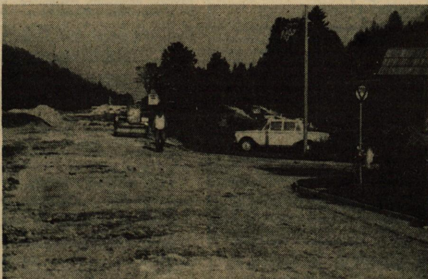
Kranjska gora - Rekonstrukcija ceste - V začetku avgusta so začeli delavci Cestnega podjetja Kranj širiti in obnavljati cesto od Kranjske gore do Podkorena. Promet zdaj poteka po lepo speljani in asfaltirani cesti na trasi nekdanje železniške proge. Nov del ceste bo nared do zime, dela pa bodo veljala nekaj več kot 7 milijonov dinarjev. Obvoznice, ki so jo ob tem zgradili, ne bodo podrli, ker je bodo uporabljali za smučarske teke ter vožnjo z vprežnimi sanmi. - Foto: B. B.
