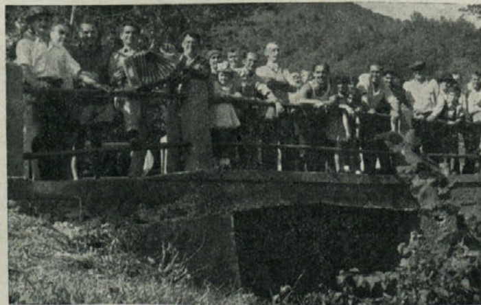
Ni dolgo od tega, ko so v Jakšičih v Kostelu zgradili nov most (Vaščani na novem mostu)
