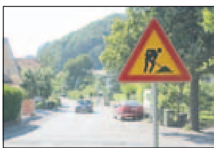
Med poletjem so delavci Cestnega podjetja Ljubljana nadaljevali z obnovo Dragomerške ceste.
