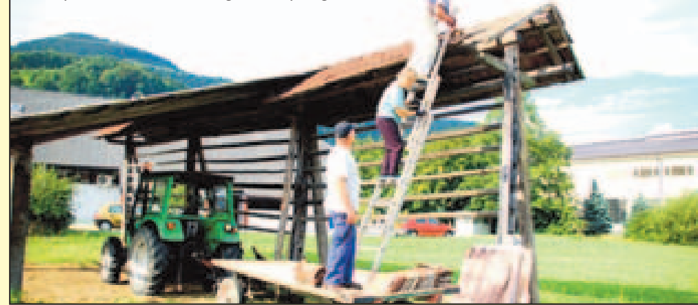
Rušenje več kot 120 let starega Andrejevega kozolca
