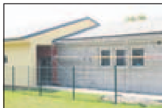
Na dragomerškem vrtcu so delavci med poletjem zamenjali okna.
