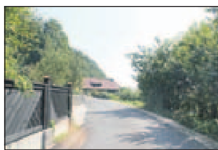
Asfaltirali so tudi loško Cesto na Breg.
