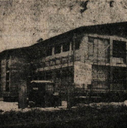
Novo šolsko poslopje je že pod streho
