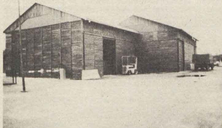
V tozdu BOR v Krškem so zgradili dva prepotrebna pokrita skladiščna objekta. S tem so pridobili prepotraben prostor za skladiščenje. Z izgradnjo teh objektov so spremenili tudi lice tovarne.
