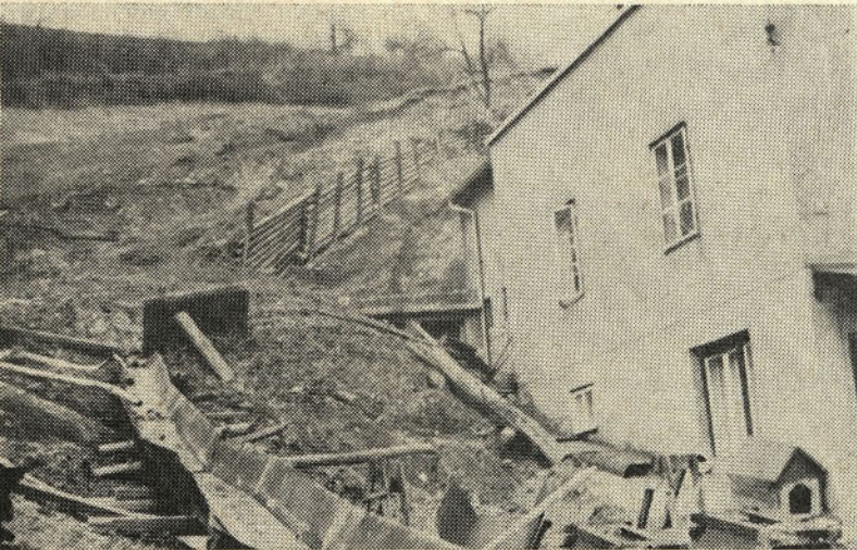
Tako spodriva plaz hišo v bližini pošte v Hrastniku
