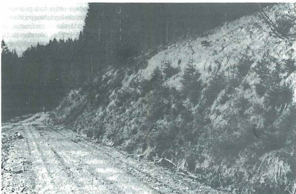
Naravno zaraščanje odkopne brežine na gozdni cesti le nekaj let po gradnji (foto: mag. A. Dobre)
