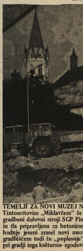
TEMELJI ZA NOVI MUZEJ NOB - Pod novomeškim kapitljem s Tintoretovim „Miklavžem“ že od sredine letošnjega poletja brnijo gradbeni delovni stroji SGP Pionir. Izkopje so v glavnem opravljene in tla pripravljena za betoniranje temeljev, na katerih bo do prihodnje jeseni zrasedel novi muzej NOB in ljudske revolucije. Nad gradbiščem tudi že „poplesuje“ velikanski žerjav, ki ga uporabljajo pri gradnji tega kulturno-zgodovinskega objekta. (Foto: I. Zoran)
