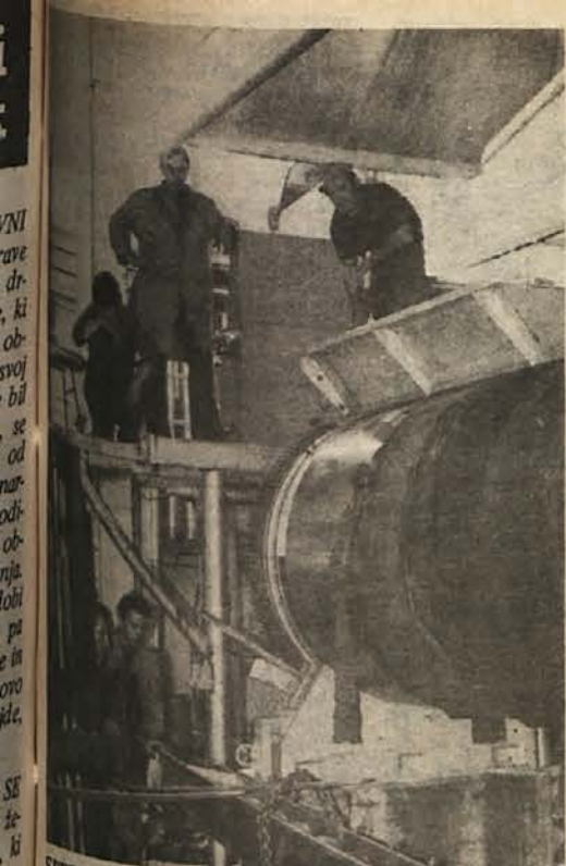
SPET S POLNO PARO — Konec minulega tedna so v mirenski Kolinski ob pomoči dveh francoskih monterjev ponovno nameščali 17-tonski sušilni valj. Le-ta je bil to poletje na popravilu v Franciji. Po zagotovilih strokovnjakov naj bi ga bili včeraj že pognali. (Foto: Železnik)
