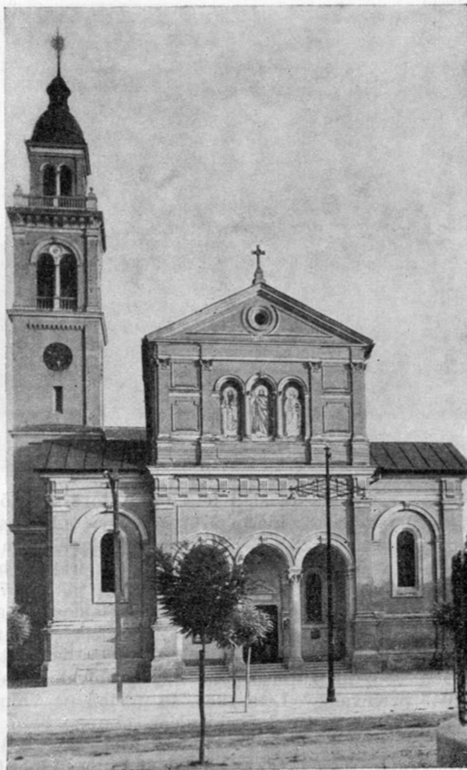
PROČELJE ŽUPNE CERKVE SV. ANTONA NA VIČU
