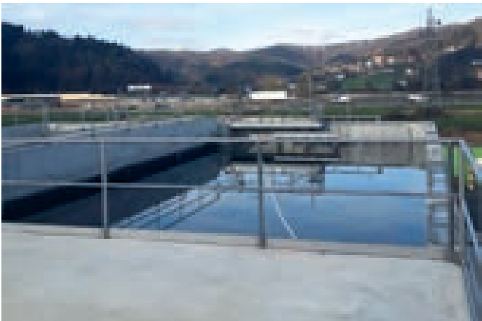
Z zaključkom gradnje kanalizacijskega omrežja, ki je zdaj položeno po vseh treh naseljih – Lukovici, Dragomerju in Logu – je Občina zaključila svoj najpomembnejši infrastrukturni projekt doslej. Projekt ni bil obsežen le zaradi količine opravljenih ur in del, temveč tudi zaradi izjemnega finančnega vložka. Šlo je za najdražji projekt v zgodovini občine, hkrati je občina za izvedbo pridobila največ sofinancerskih sredstev doslej. Skupna vrednost projekta je znašala vrtoglavih 12,7 milijona evrov, od tega je bilo 9 milijonov Evrov sofinanciranih.
