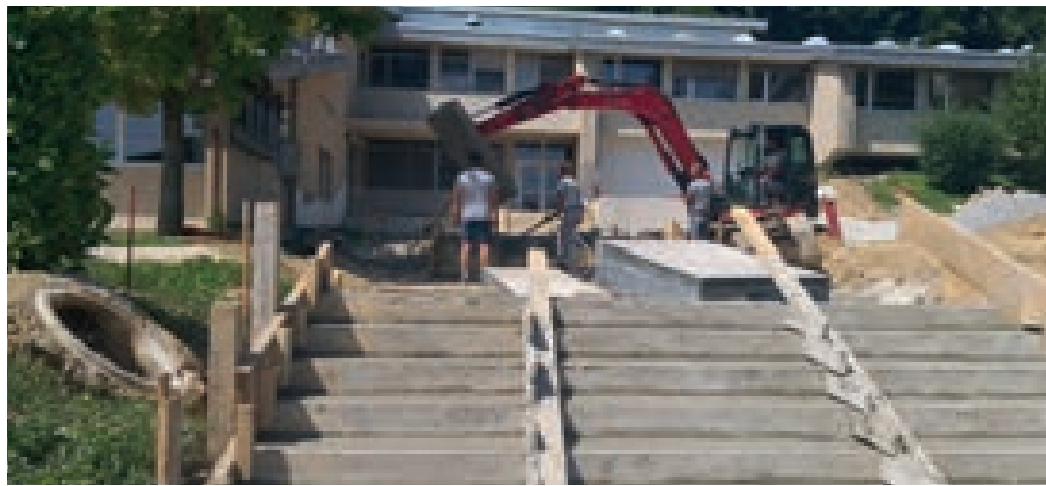
Začetek gradnje novega vhoda v šolo.
