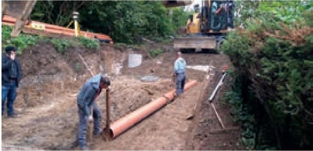
Polaganje cevi med gradnjo infrastrukture na Lesnem Brdu.
