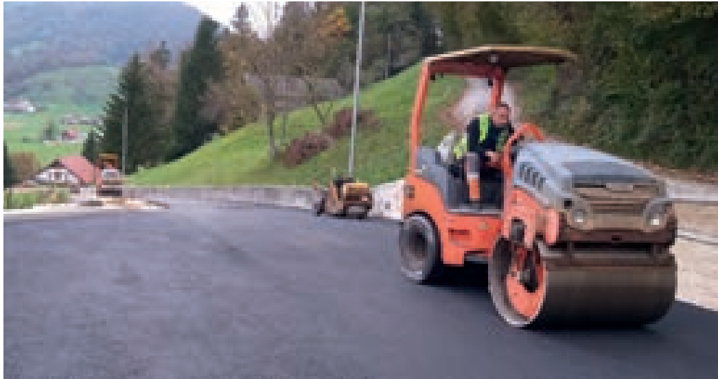
Asfaltiranje ceste je še zaključno dejanje rekonstrukcije ceste od Mostarja do cerkve na Lesnem Brdu.
