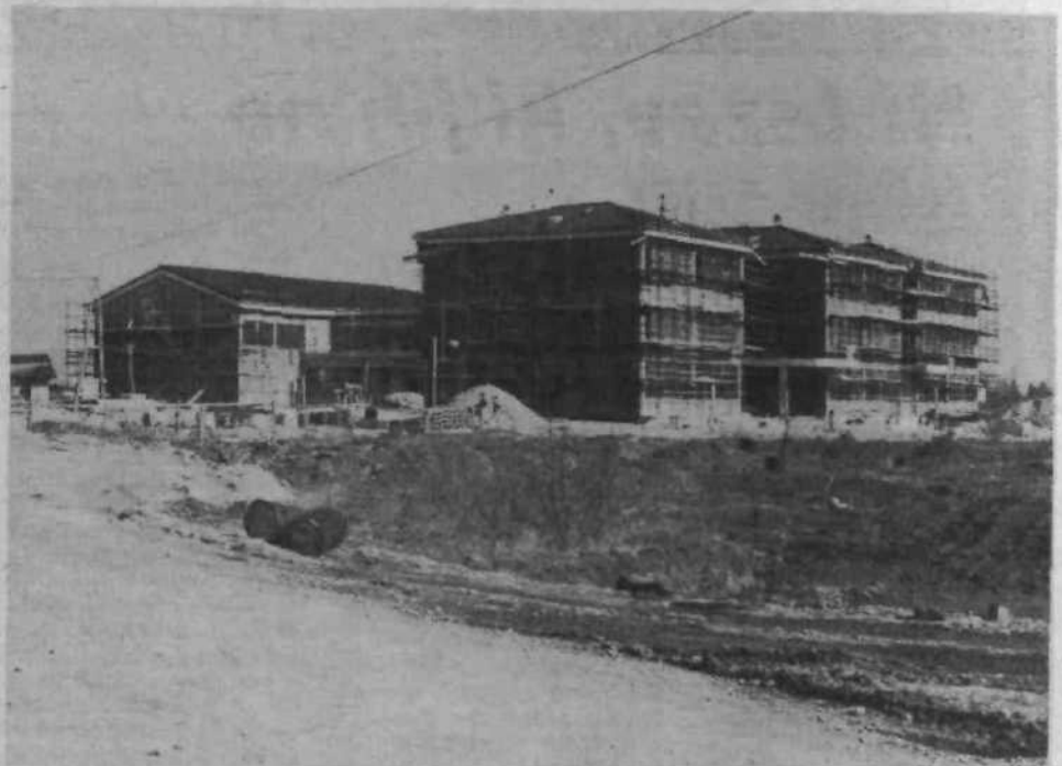
SE ENA ŠOLA IZ SAMOPRISPEVKA – Vzgojni zavod Janeza Levca se bo jeseni preselil v nove prostore za Bežigradom. Predvidevajo, da bo gradnja končana že junija, v začetku julija pa bo tehnični prevzem. V napovedih se verjetno niso zmotili, kar dokazuje tudi zunanji videz zgradbe.
