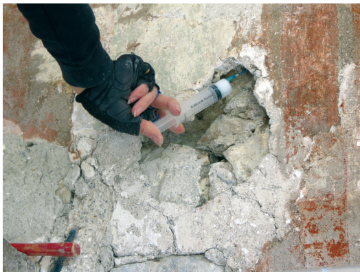
Mikroinjektiranje podvotljenega in nestabilnega ometa. (foto: Anita Klančar Kavčič)
