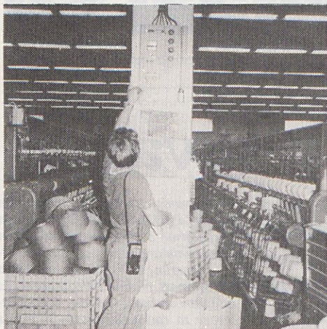
Dežurni klimar Dušan pregleduje delovanje avtomatike za uravnavanje temperature in vlage v sukalnici.
