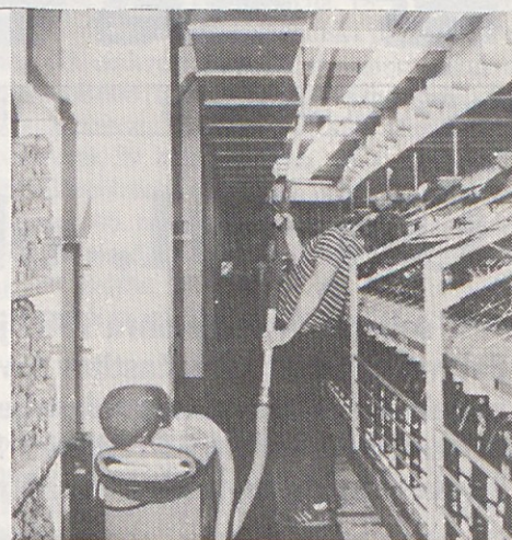
Klemen čisti klimatske kanale z industrijskim sesalcem.
