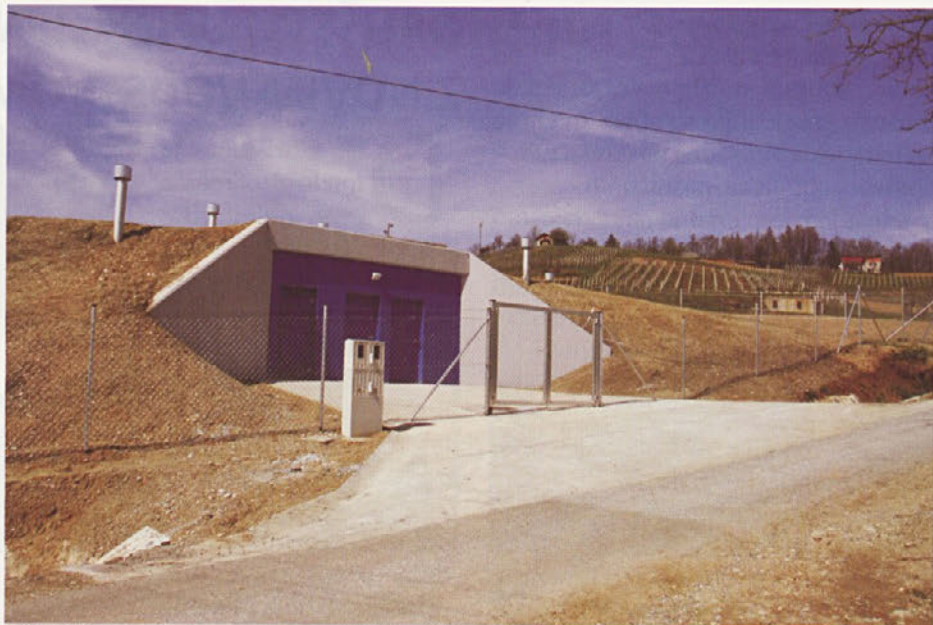
Vodohram v Zamušanih
