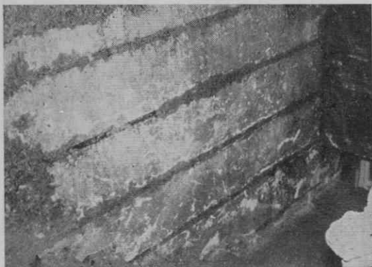
Sl. 11. Gruberjeva palača, podstrešje, fugiran omet na stopniščni strani južnega zidu, jugovzhodni del
