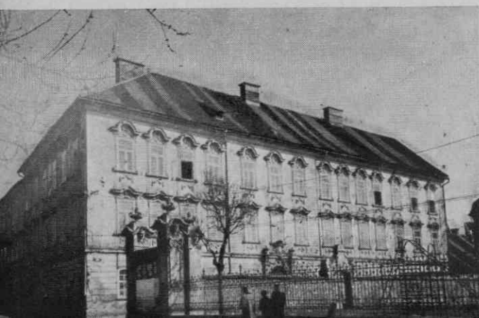
Sl. 1. Gruberjeva palača — zahodna fasada
