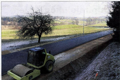
Zaradi težav pri odkupu zemljišč dela počasneje napredujejo.
