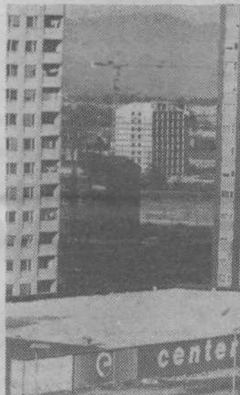
Visoki žerjav je že »dvignil« prvi stolpček v Novih Fužinah. Od Štepanjskega naselja pa ga loči le Ljubljana. (Foto: HVASTIJA)
