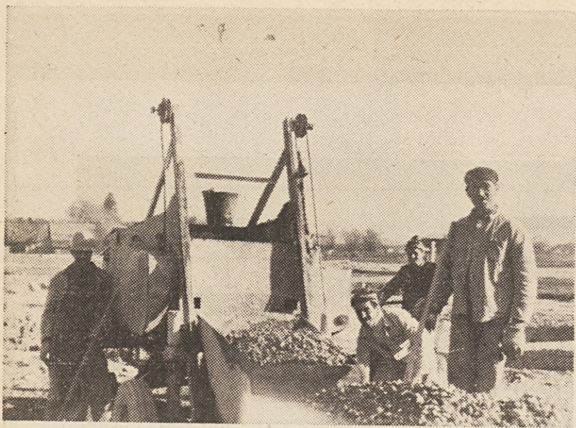
Gradnja novih hal na Ravnah za proizvodnjo nožev
