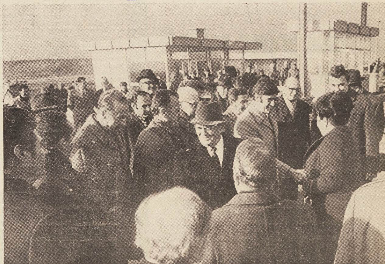
Na začetku avtomobilske ceste se je kolona avtomobilov s predsednikom Titom ustavila, direktor cestnega sklada ing. Blenkuš pa mu je »raportiral«, kako so tekla dela na cesti. Drugi z leve je naš glavni direktor
