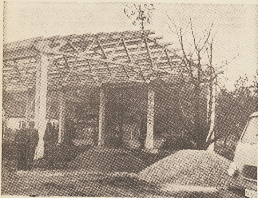
Tale manjša industrijska hala v Mariboru je bila postavljena v dveh dneh
