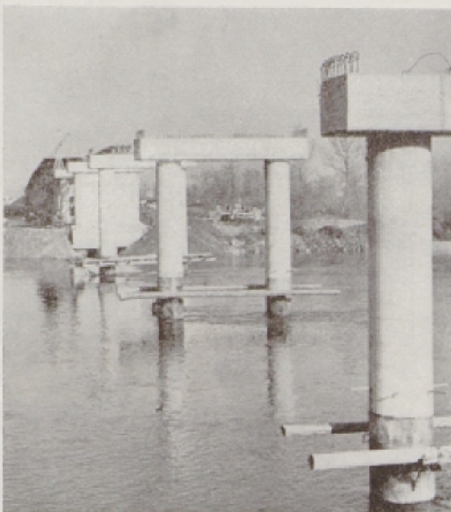
Obrisi novega mostu prek Save pri Brežicah so že vidni. Most bo končan junija letos. Foto: Janez Zrnc
