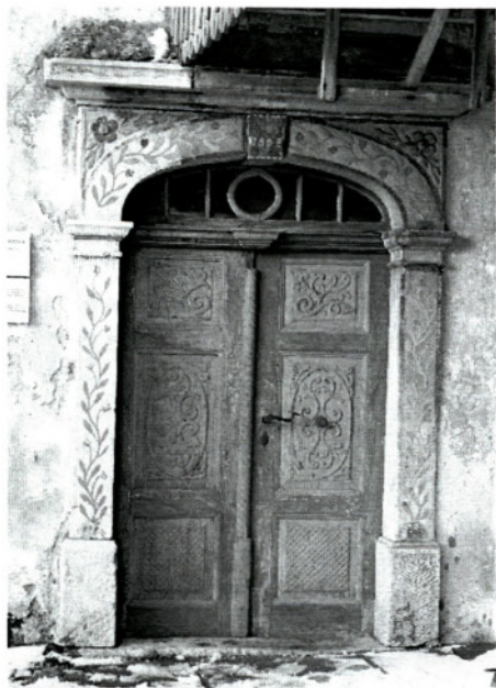
Vhod zavarovane Plešnarjeve domačije
