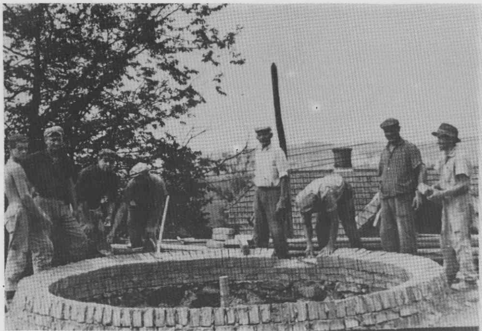
Lukmanovo apnenico obnavljajo, Podpeč 1966
