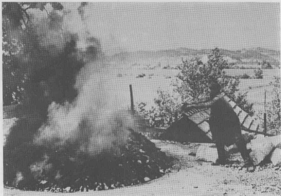
Zgornji del apnenice, prižgana kopa, Grebenčeva apnenica, Podpeč 26. Posneto 1972, Žnidaršič Joco, objavljeno v Tov. 23/1972
