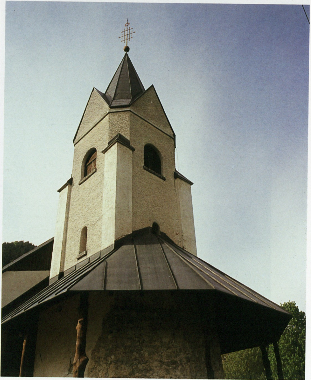
Foto von der Fassade von Süd
