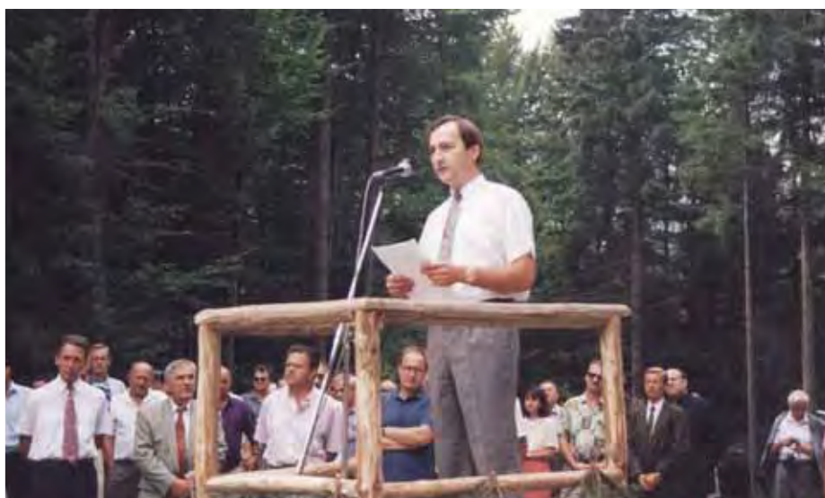
Zaključek obnove ceste v Kamniško Bistrico, ki je bila poškodovana v neurjih jeseni 1990. (avgust 1993) (Foto: arhiv Mihaela Novaka)
