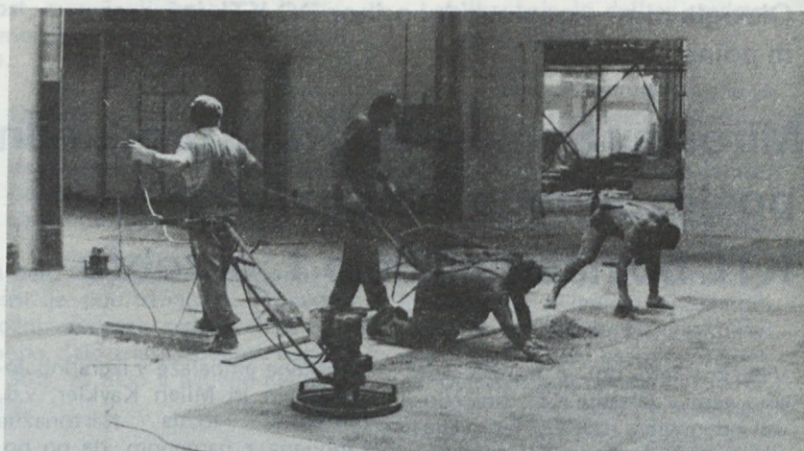
Zaključna dela delavcev Slikopleskarska pri polaganju "epoksi" tlaka v proizvodnih prostorih
