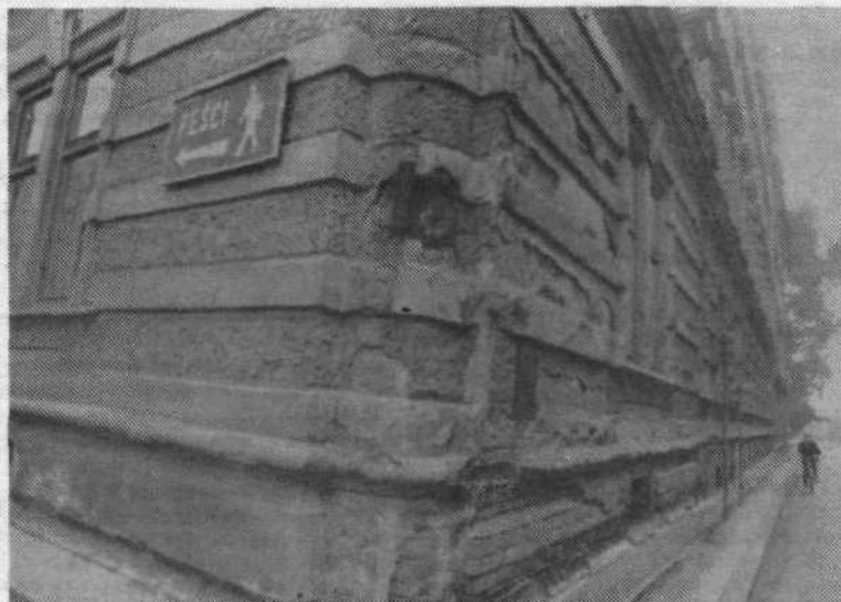
Na vogalu Rimske in Kardeljeve ulice lahko vidimo takšne podobe razpadajoče stene. Krivda je bržčas na gostem prometu, ki poteka tesno ob hišah in brzga curke vode na hišno pročelje. Kdo je v resnici odgovoren in koliko časa še? Podoba, kjer je vsak dan tudi veliko tujih obiskovalcev našega mesta, je vse prej kot prijetna.
