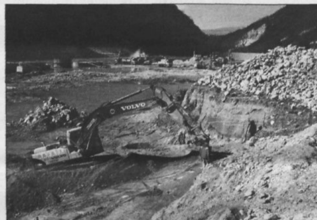
Gradbišče HE Krško
