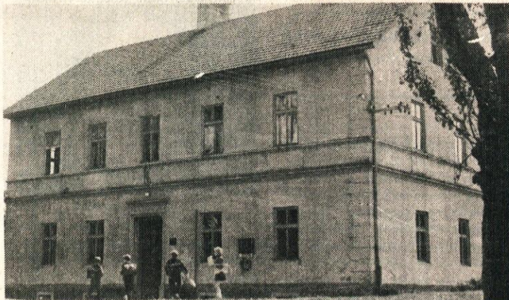
Šolska zgradba na Dolah je dotrajana, saj je bila leta 1943 požgana in po vojni le zasilno obnovljena.
