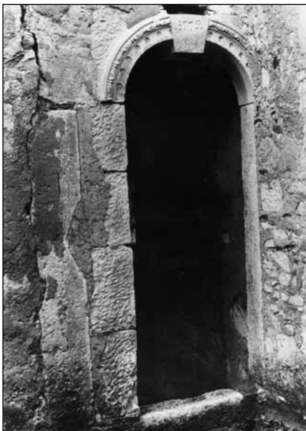
Sl. 8: Sekundarno iskorišteni dijelovi renesansne monofore sa zaglavnim kamenom iz 1776. godine, koji datira jednu od adaptacija utvrđene plemićke rezidencije (fototeka Konzervatorskoga odjela u Rijeci).
