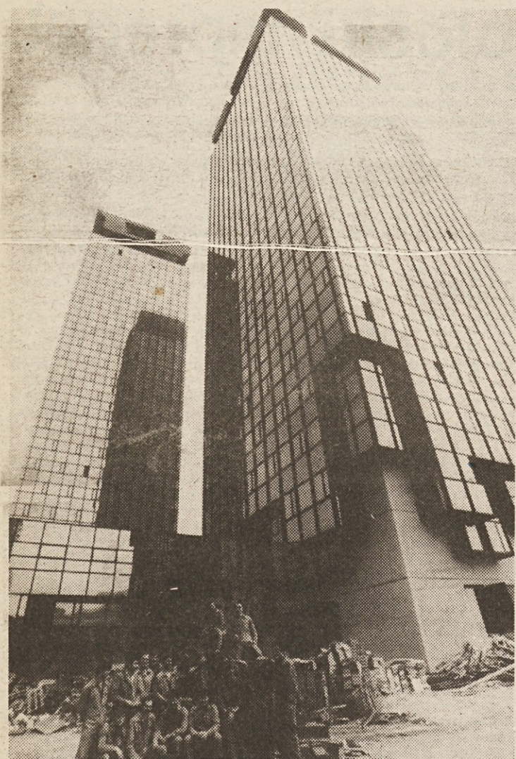
Dvigalovi fantje, ki izvajajo montažna dela na objektu Unis Sarajevo
