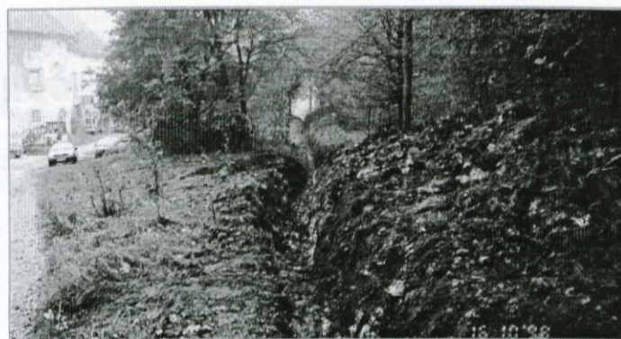
Obnova vodovoda Dobeno.
