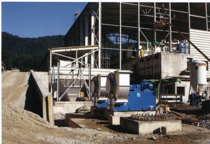
Gradnja elektro filtra
