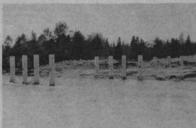
In že smo pri Savi. Dela tečejo na obeh bregovih, postavljeni so že vsi nosilni stebri – to ni bilo majhno delo. Tudi visoka voda jim je v zadnjih dneh pomagala, nekajkrat odnesla nasipe, pa vendar so obrisi mostu na desnem bregu Save že vidni.
