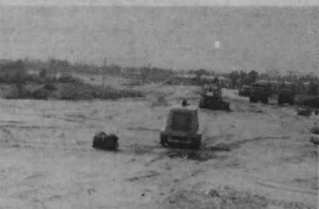
Tudi levo od Titove ceste s štajerske strani je trasa, ki vodi mimo črnuške industrijske cone, že lepo vidna. Močvirnati teren z ilovico gradbenikom ni naredil preveč težav, le nadvoz nad kamniško progo bo stal na 25 do 30 metrov dolgih pilotih.
