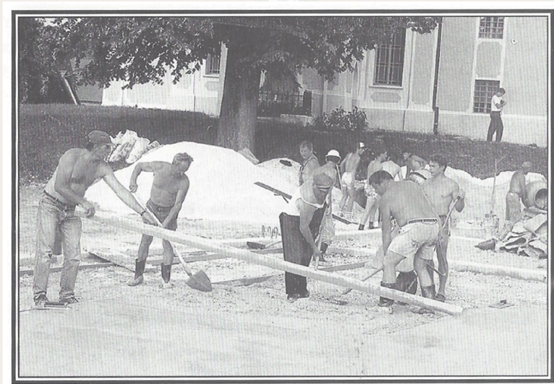
Slika 15: Vlivanje temeljev spomladi 1991 (arhiv E. Kos).
