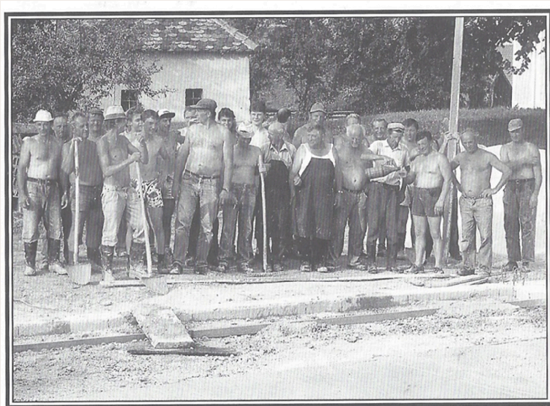
Slika 16: Začetna dela pri gradnji Slomškovega doma, poletje 1991 (arhiv E. Kos).
