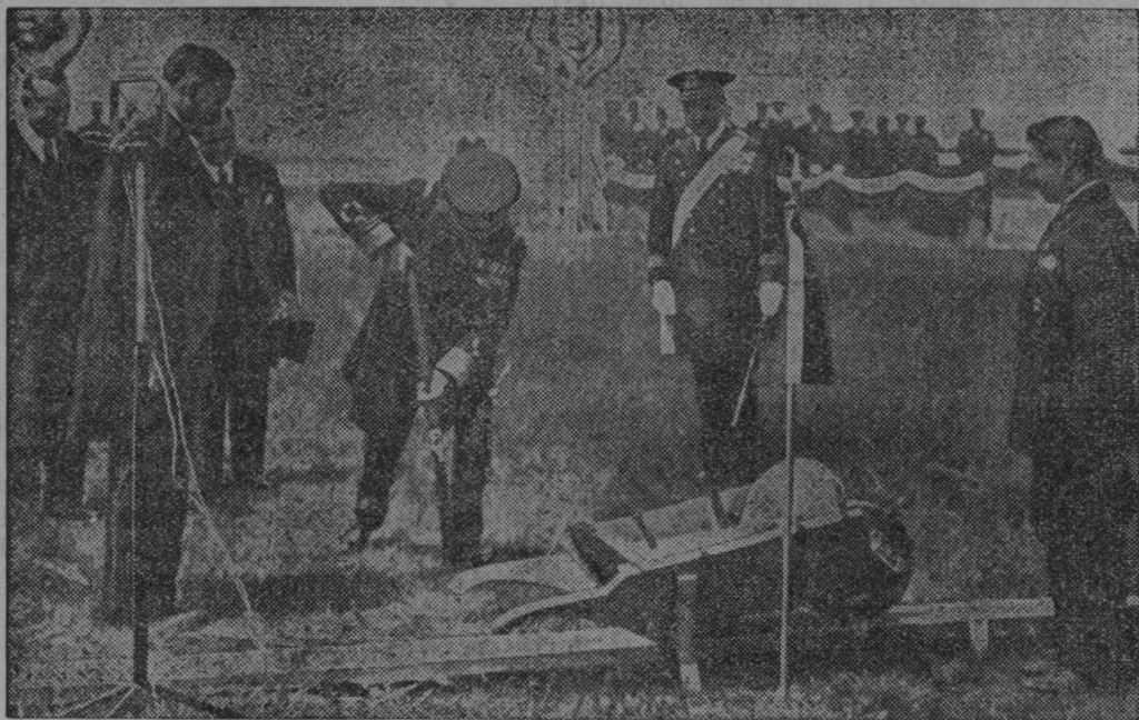
Madjarski regent Horthy zasaja lopato v zemljo in s tem slovesno odvarja zemeljska dela za zgradbo proste luke v Budimpešti.
